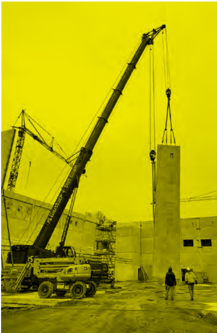
↑ Beispiel Sporthalle Für die Errichtung dieser Sporthalle wurde mit insgesamt 388 Betonfertigteilen geplant
