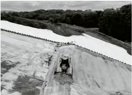
Spezialraupen mit breiten Ketten minimieren den Druck beim Einbau von Materialien. Schlepperfräsen kommen bei der Aufbereitung des mineralischen Bodenmaterials zum Einsatz
