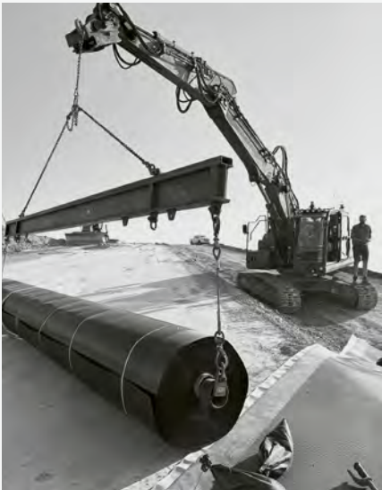
Perfekt vorbereiteter Untergrund für den Einbau Schon kleine Unebenheiten oder scharfkantige Stellen können die Bahn beschädigen. Entscheidend ist die Nahtqualität, denn Schweißarbeiten müssen auch bei wechselndem Wetter sicher und reproduzierbar gelingen. Anschlüsse und Durchdringungen sind besonders sensibel und verlangen eine lückenlose Qualitätssicherung
