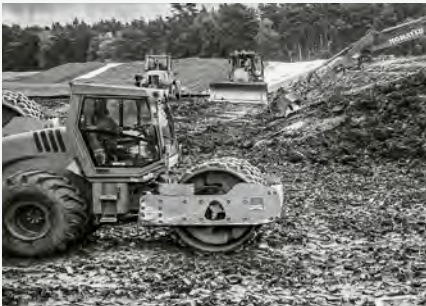
Stampffußwalzen verdichten den Boden während des Baus der Basis-Abdichtung
