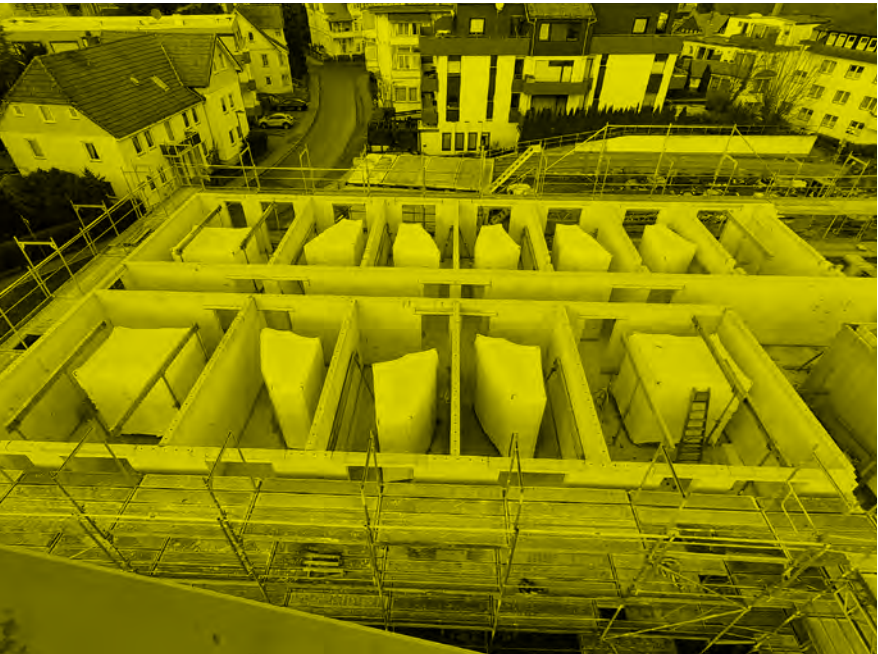
↑ Beispiel Hotelbau Die Vorfertigung der etwa 200 zwischen 2,5 und 3,5 Quadratmeter großen Nasszellen verkürzt die Gesamtbauzeit zweier Hotels um rund ein Viertel
