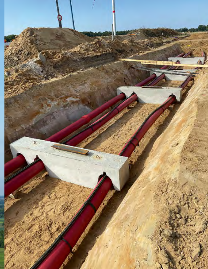
↑ Trasse mit Schutz- und Begleitleerrohren
