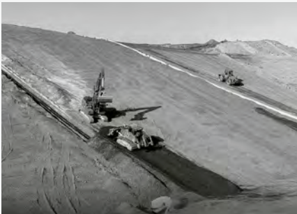
Seilwinden unterstützen den Einsatz von Walzen, um an den häufig steilen Hängen der Deponien arbeiten zu können
